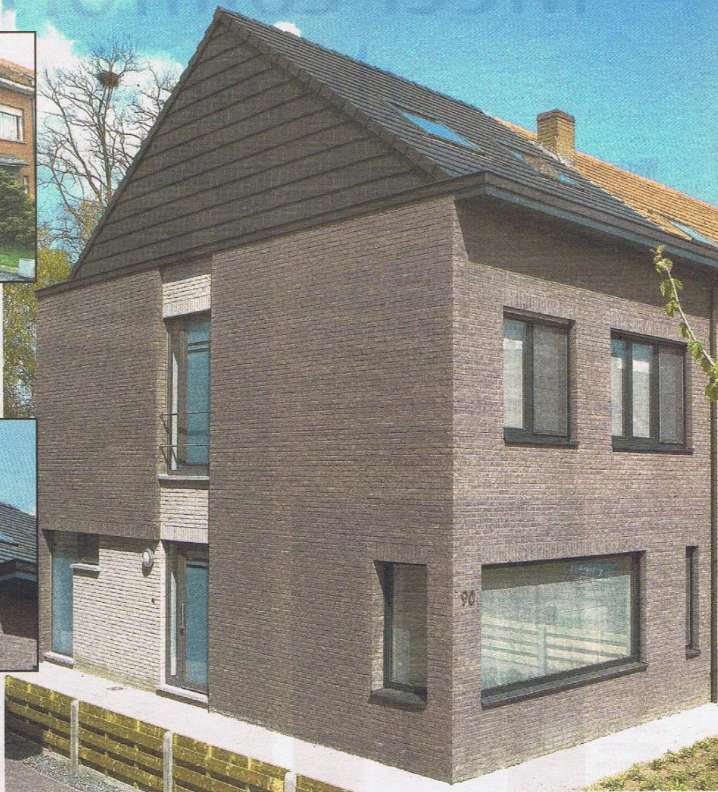
Het dak en een deel van de gevel zijn van de verbouwing bekleed met platte antracietgrijze kleidakpannen. Foto's Koramic
